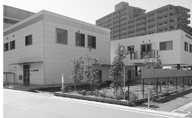
埼玉県和光市の本社・工場
